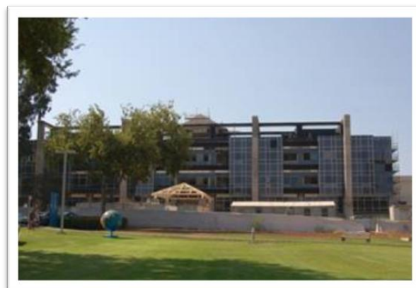
Детская больница в процессе строительства
